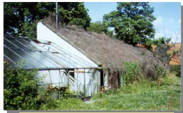
Vor der Restaurierung
